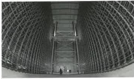
Einblick in das neue Hochregallager 38
