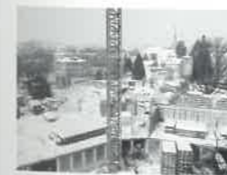
Blick auf die Baustelle der Geriatriischen Klinik, Ende der 1970er-Jahre.
