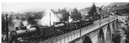
Wichtige Förderung des Eisenbahnnetzes: Mit guten Verbindungen konnten Handelswaren schneller befördert werden. Im Bild die Belastungsprobe der Kräzern-Eisenbahnbrücke im Jahr 1925, StadtASG, B, 1149.
