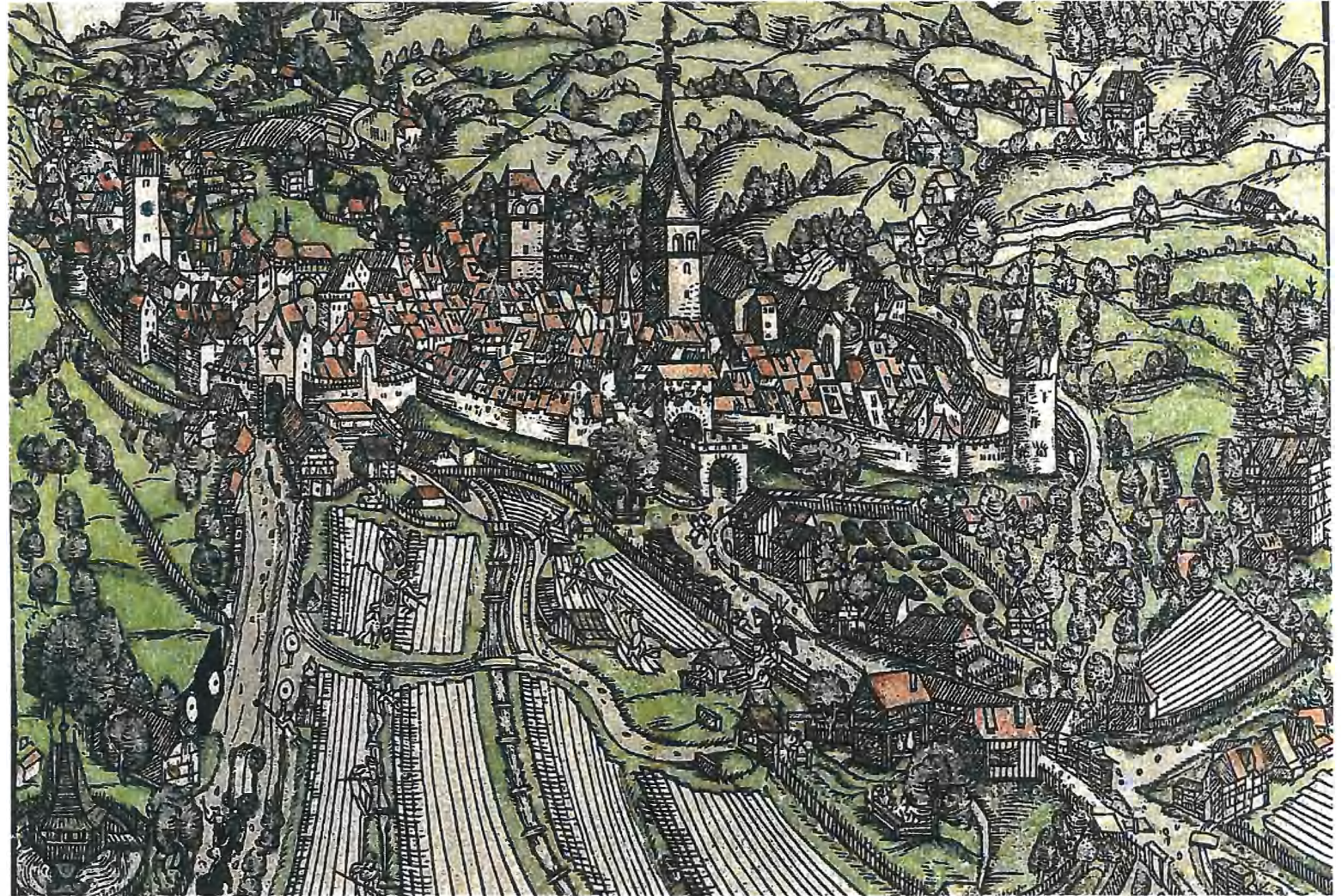
Vadian verfasste zwischen 1530 und 1546 die erste zusammenhängende Geschichte von Stadt und Region St.Gallen. Die Beschreibung der Stadt wird mit ihrer ältesten kolorierten Ansicht von 1545 (Bild) eingeleitet. Sie ist darauf von Westen her dargestellt. Im Vordergrund sind die Felder zu erkennen, auf denen damals die Leinentücher zum Bleichen ausgelegt wurden. Darauf steht heute das Bahnquartier.
