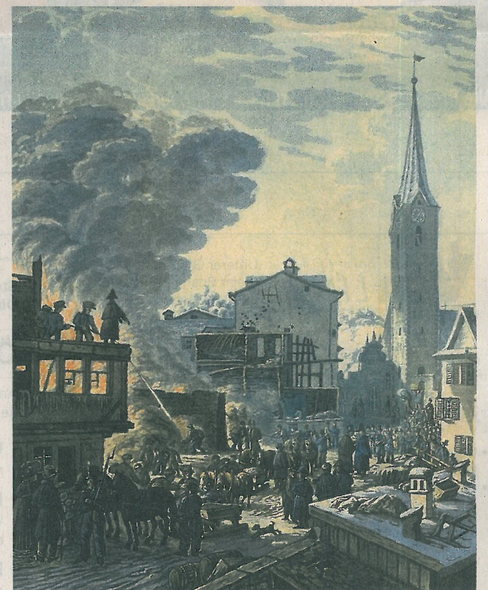
Brand an der Magnihalde in St. Gallen am 27. Januar 1830. Das Feuer galt als das grösste und gefährlichste in der Stadt seit 1650. Es zerstörte zwölf Gebäude. Acht Personen kamen ums Leben.
