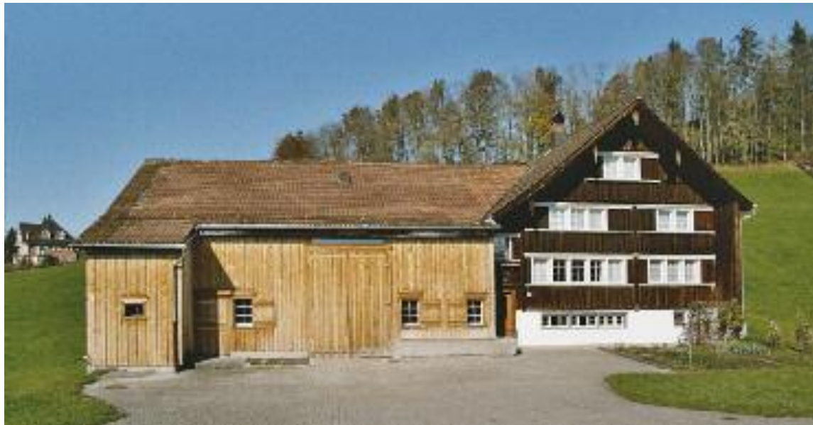
Abb. 3: Bis ins 18. Jahrhundert dominierte in der ländlichen Textilproduktion der Ostschweiz die Verbindung von Landwirtschaft und textiler Heimarbeit. Das abgebildete Weberbauernhaus in Teufen, Egglistrasse 14, ist der in Ausserrhoden am häufigsten vorkommende Haustyp mit mehrgeschossigem Wohnteil mit Fensterreihen sowie Webkeller im Untergeschoss. Der Stall ist an das Haus angebaut. Die Firste beider Hausteile stehen in Kreuzstellung (90 Grad-Winkel) zueinander. (Foto: Denkmalpflege Appenzell Ausserrhoden, 2004).
