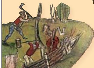
Bau einer Sperranlage
