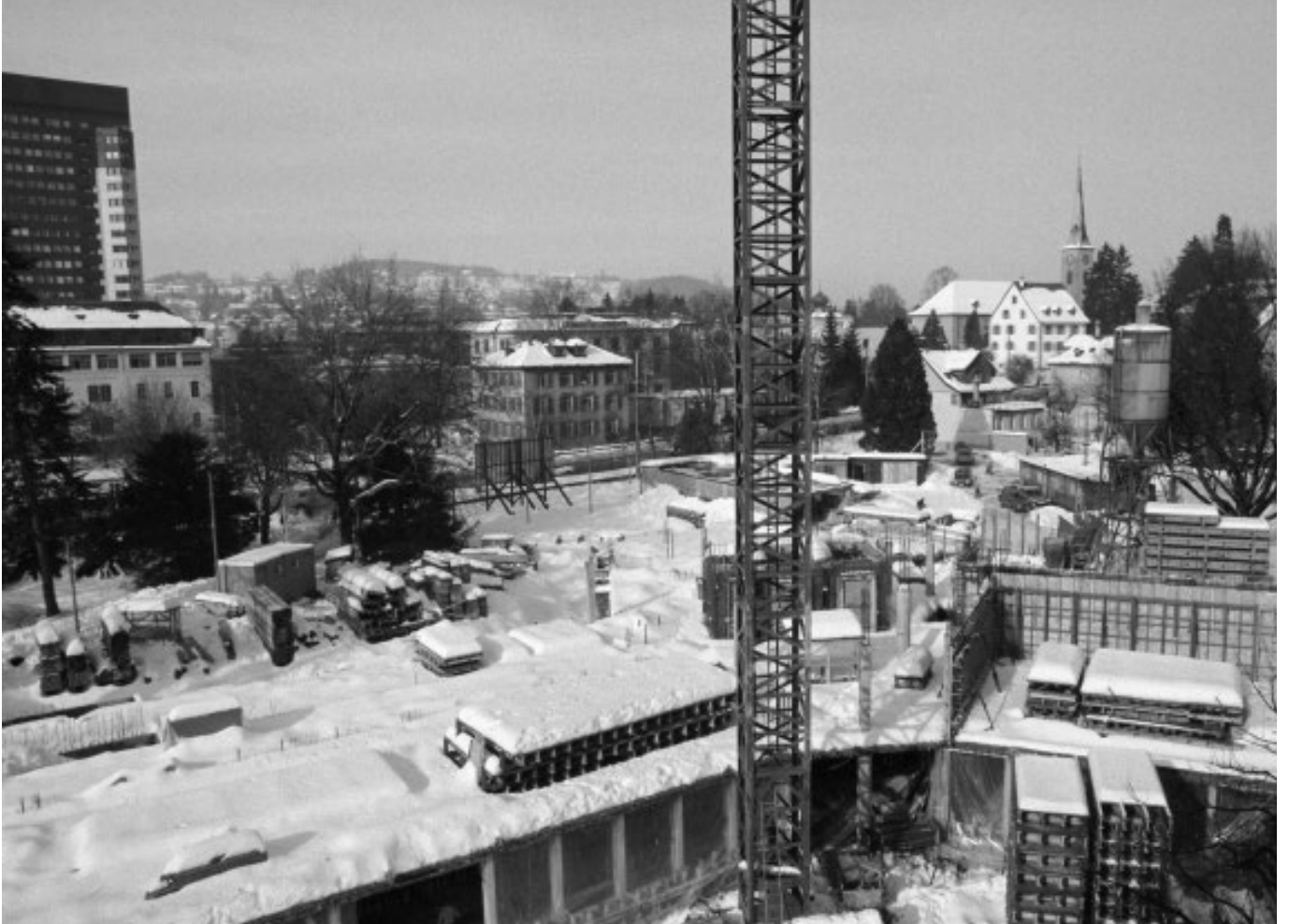
Ansicht der Baustelle StadtASG, PA Kühne Künzler, 1995_III_26.
