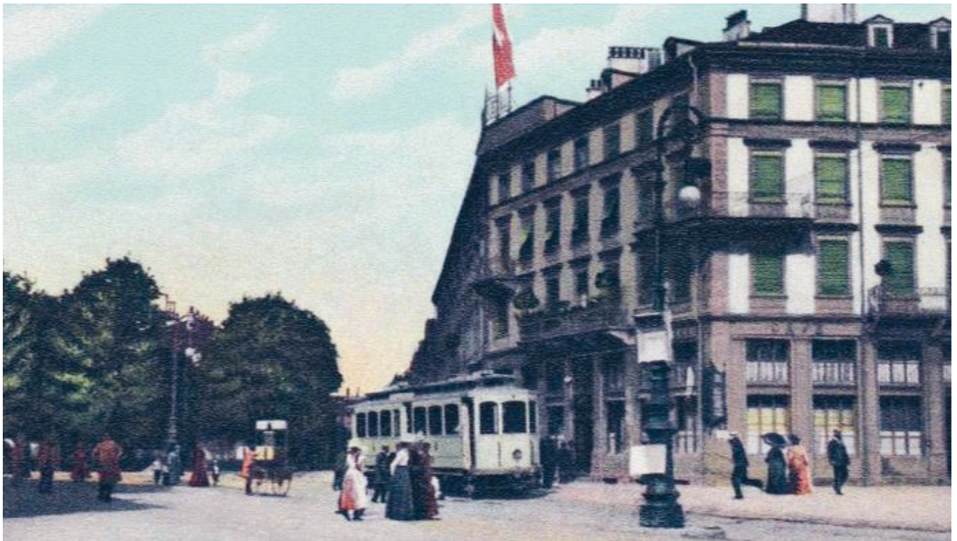
Die St.Galler Post zog 1861 vom Posthaus – dem heutigen Stadthaus – an den Bahnhof ins Vorgängergebäude des «Walhalla». StadtASG, B, 1892
