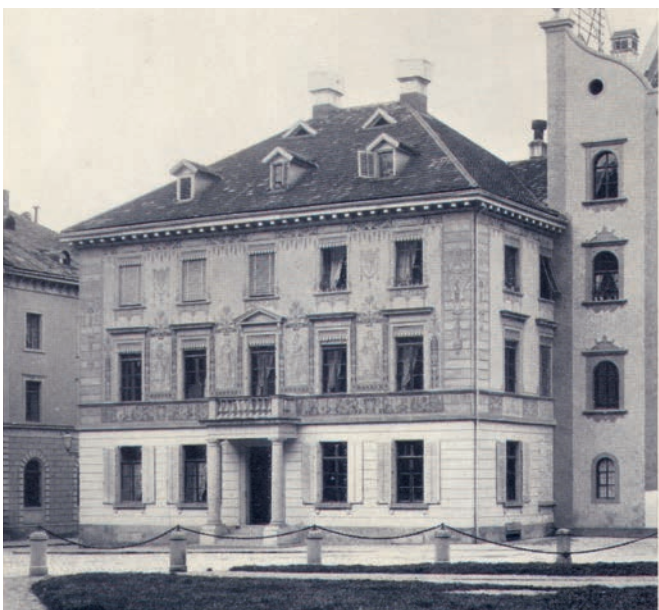
Das Kaufmännische Directorium – die heutige IHK – verliess das Posthaus, in dem es während fast 100 Jahren domiziliert gewesen war, im Jahr 1864. Der Umzug gestaltete sich nicht sonderlich aufwendig: Er führte ins Nebengebäude, in dem die IHK sich noch heute befindet. Die historischen Fresken wurden anlässlich einer Renovation zerstört. StadtASG, B, 147.
