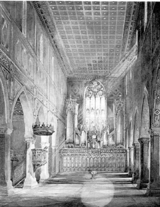
Vision des Inneren der St. Laurenzenkirche nach einem Aquarell des Architekten Johann Georg Müller, 1845 (Stadtarchiv der Ortsbürgergemeinde St.Gallen)
