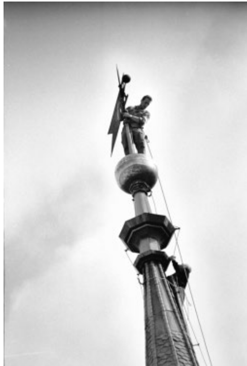
Schwindelerregende Arbeit auf der Turmspitze im Jahr 1965 (Stadtarchive St.Gallen, PA Künzler Kühne)
