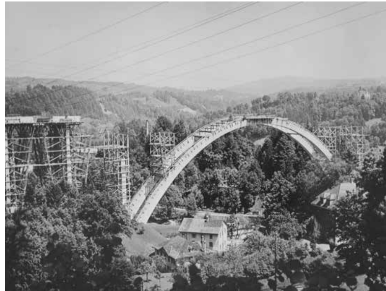
Im Juni 1939 wurden die Strassen rechts und links des Sittertobels mit dem Brückenbogen verbunden. (StadtASG, PA Zumbühl, Fürstenlandbrücke, 200)
